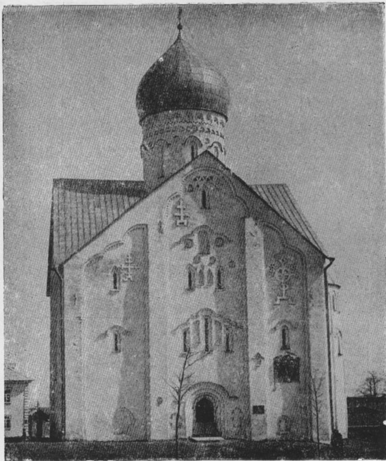
Церковь Спаса Преображения на Ильине улице. 1374 г. Южная сторона.
