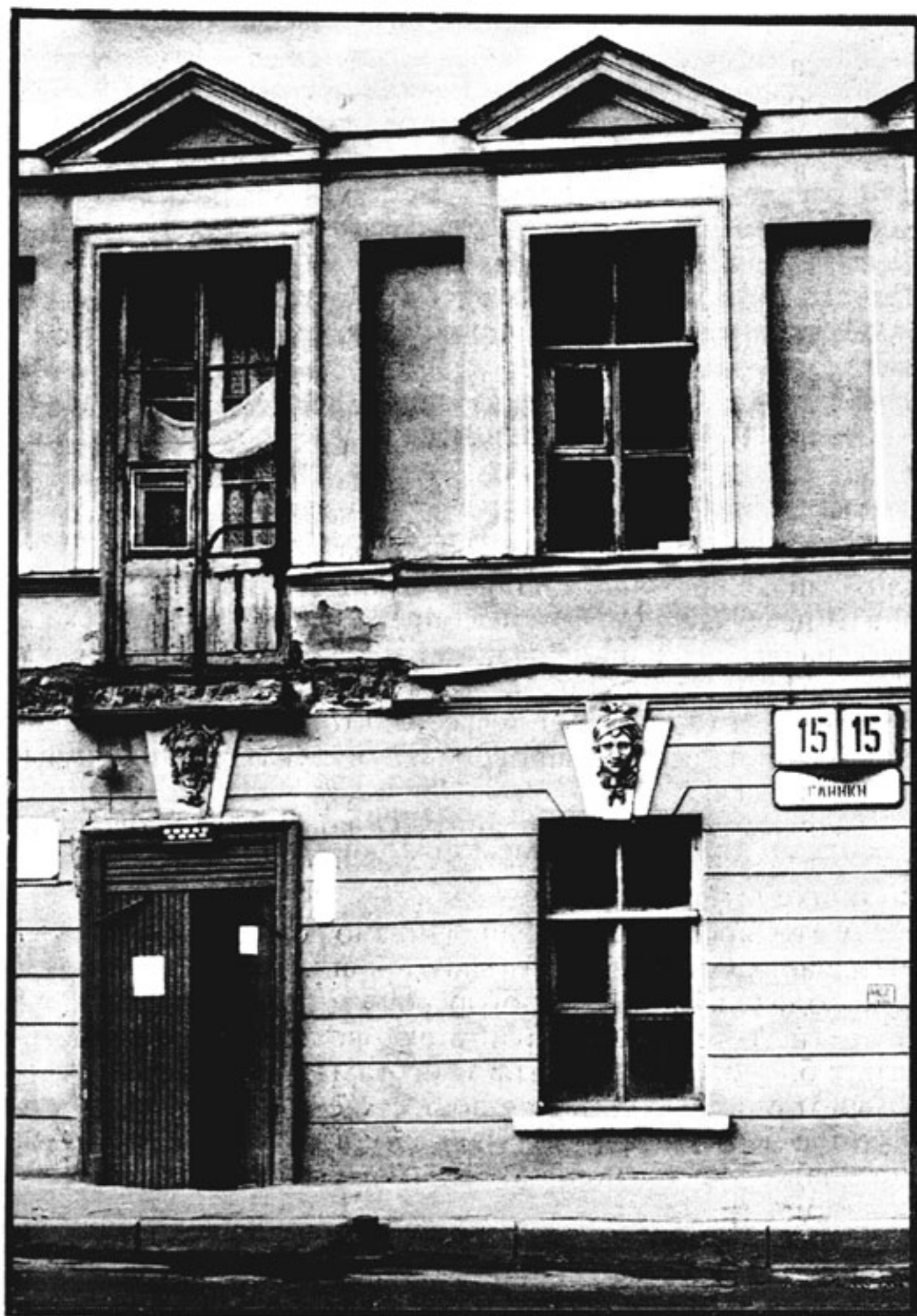
Фрагмент дома А. Бенуа в Ленинграде
